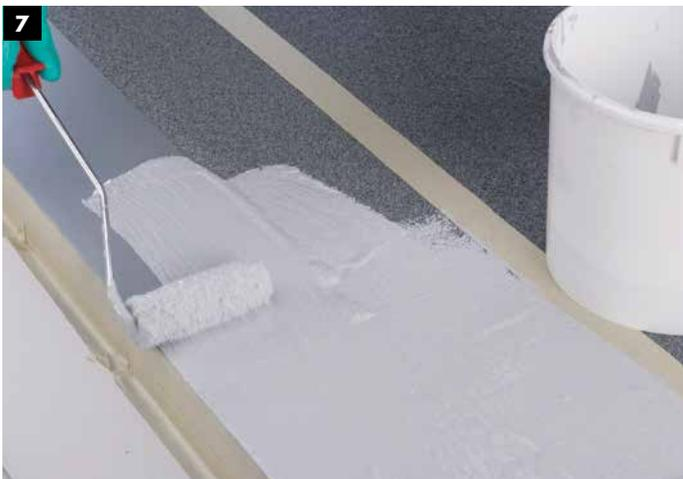
7 Satte Vorlage des Abdichtungsharzes 1K-Flachdachdicht Pro (2 kg/m<sup>2</sup>) mit Pinsel oder Rolle.
