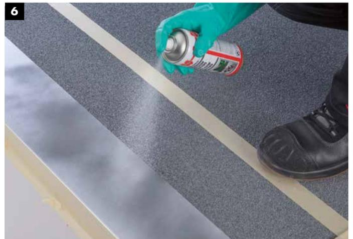
6 Aufsprühen der Grundierung Roststop Quattro. Danach Trocknungszeit der Grundierung beachten.
