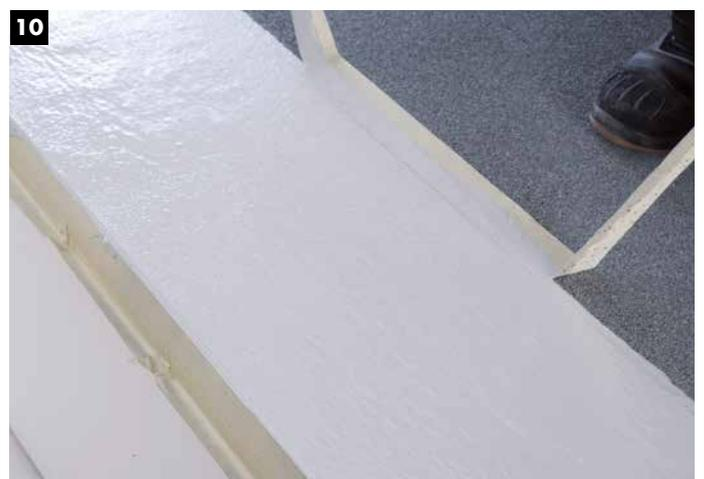
10 Verschleifen des Materials und Entfernen des Klebebandes in frischem Zustand. Das Ergebnis ist ein regelkonform und sauber abgedichtetes Traufblech.
