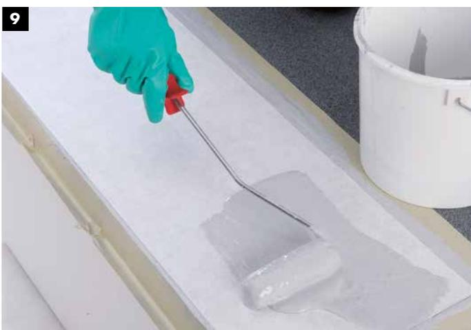
9 Auftrag der Decklage (1 kg/m<sup>2</sup>).
