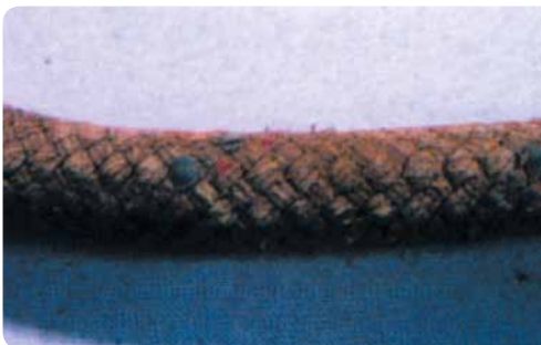
Abb. 10: Versprödung eines Kern-Mantel- Seiles durch tiefreichende Verschmutzung
