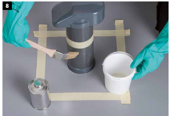
8 Grundieren des Lüfters und der PVC Dachbahn mit 1K-Flachdachdicht Grundierung. Filmbildender, aber dünner Auftrag mit Pinsel oder Rolle.
