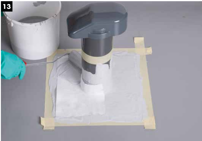
Auftrag der Deckschicht (ca. 1 kg/m 2 ).
