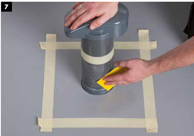
7 Mechanisches Aufrauen des Lüfters und der PVC Dachbahn, z.B. mit 80er Schleifpapier.
