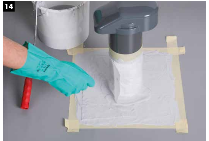
Einarbeitung der Zusatzmanschette Vlies (15 cm hoch). Zu beachten: 5 cm Überlappung und Vliesdurchtränkung.
