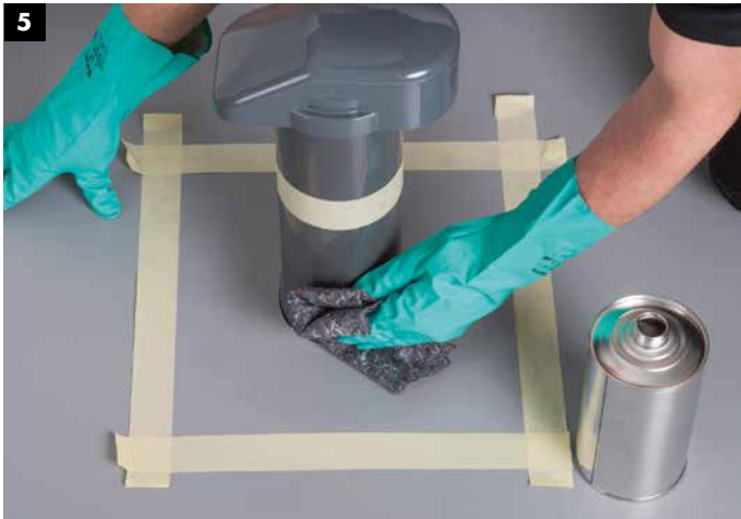
5 Entfetten und Säubern mit Aceton-Reiniger.
