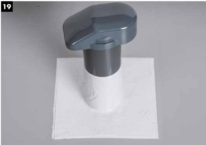
19 Regelkonform und ansprechend abgedichteter Lüfter. Fertig!
