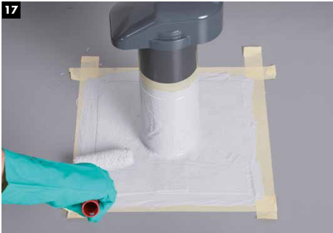
17 Verschleifung des Materials für eine gute Optik und gleichmäßige Schichtdicke.
