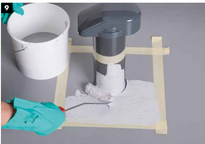
9 Satte Vorlage (ca. 2 kg/m 2 ) des Abdichtungsharzes 1K-Flachdachdicht Pro. Auftrag mit Pinsel oder Rolle.
