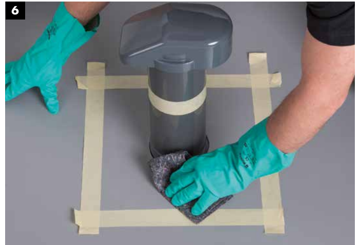
6 Sowohl Lüfter als auch PVC Dachbahn.
