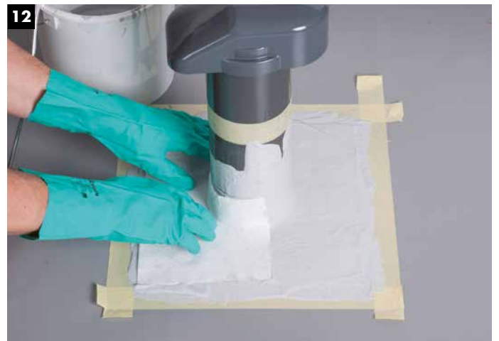
Einarbeitung weiterer Zuschnitte. Zu beachten: Vliese müssen mind. 5 cm überlappen. Auch im Überlappungsbereich ist auf rückseitige Vliesdurchtränkung zu achten!
