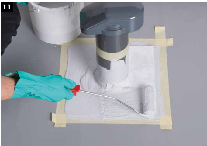
Auftrag der Deckschicht (ca. 1 kg/m 2 ).
