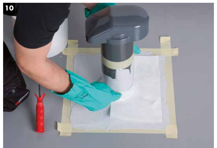
10 Einlage der vorbereiteten Vlieszuschnitte. Zu beachten: Keine Luftblasen, Vlies muss rückseitig vollständig benetzt sein.
