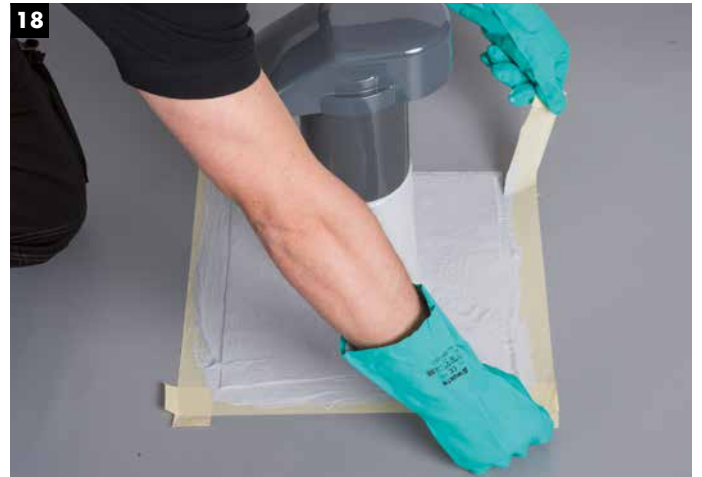
18 Entfernen des Klebebandes in frischem Zustand.
