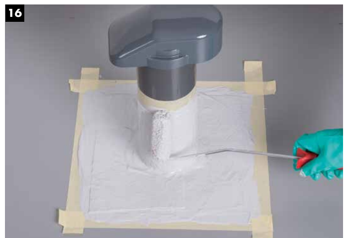
Auftrag der letzten Deckschicht.
