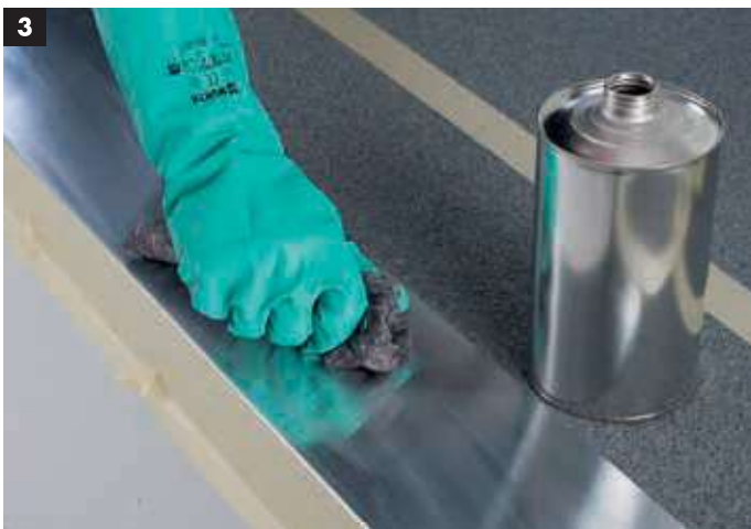
Säubern und entfetten des Blechs mit Aceton-Reiniger. Danach Abluftzeit des Reinigers beachten.
