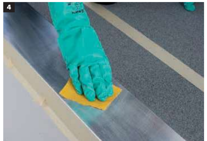
Anrauen des Bleches (z.B. mit 80er Schleifpapier).
